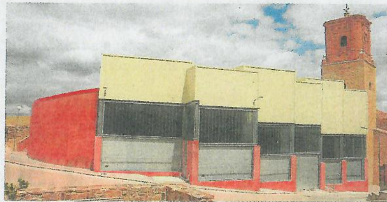
Vista del pabellón multiusos de Cubel. LORENTE ARQUITECTOS INGENIEROS
