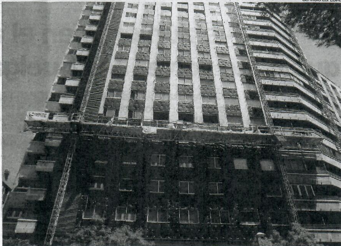
► Las obras en la fachada del edificio Torresol de la avenida de Valencia, para favorecer la eficiencia energética.
